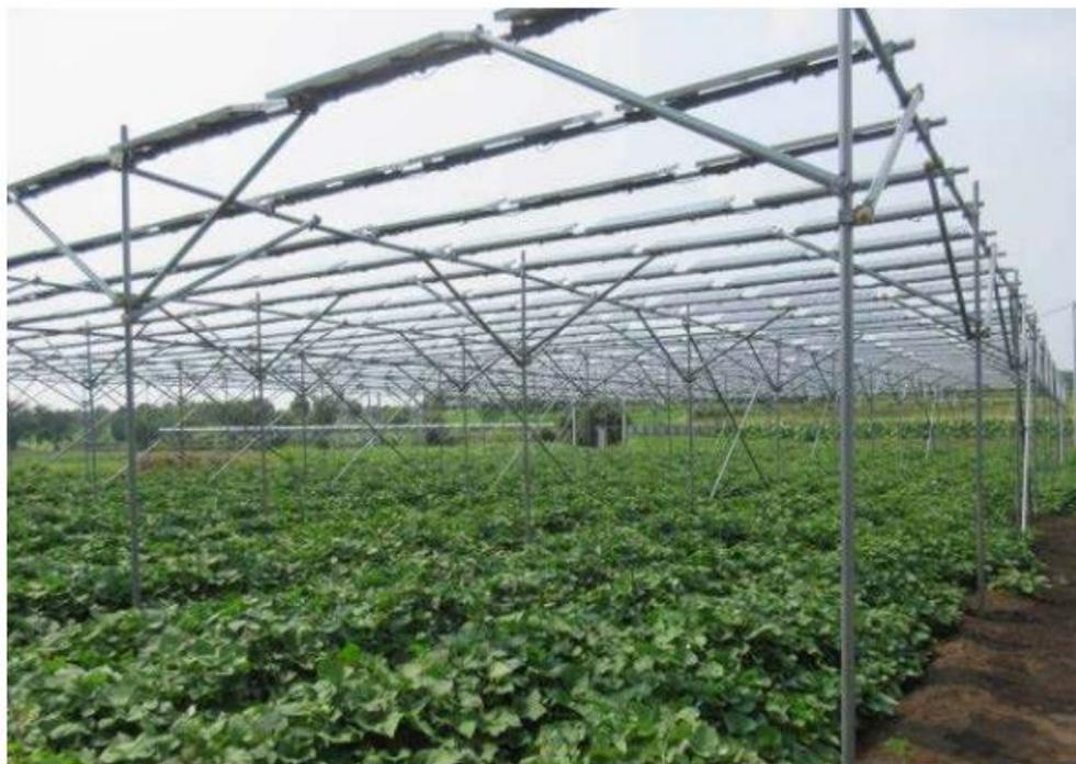
露地の畑の上部に太陽電池モジュールを設置
