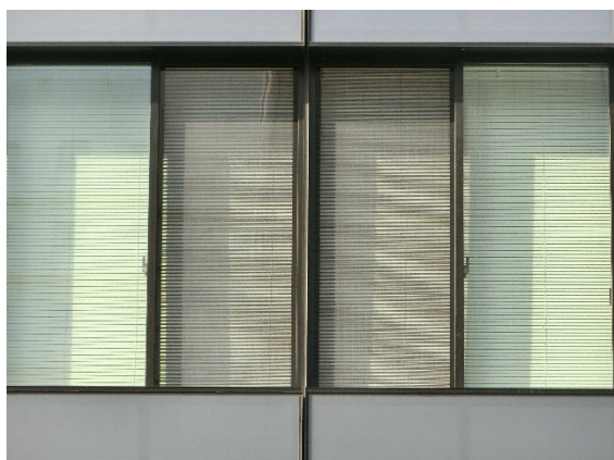
大成建設横浜支店太陽光発電設備 「シースルータイプ」
