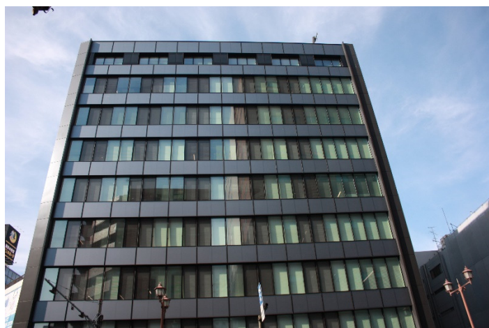
大成建設横浜支店太陽光発電設備(その2)
