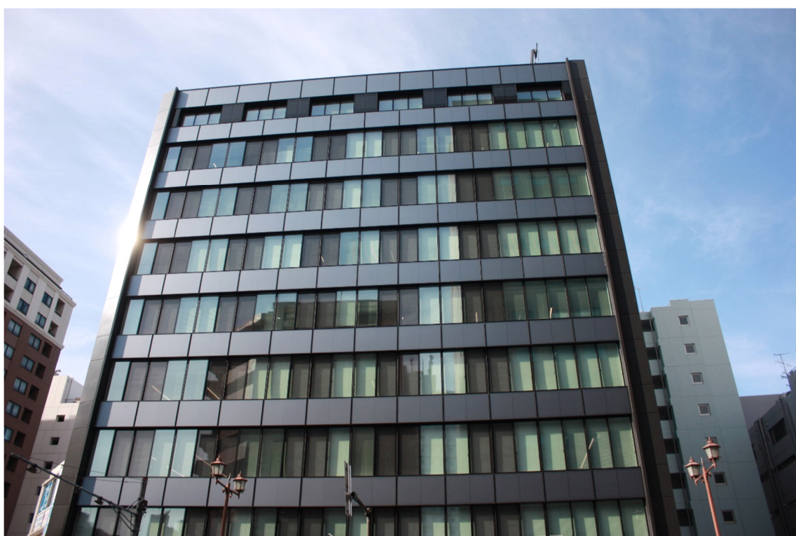
神奈川県・ZEB Ready大成建設横浜支店太陽光発電外装システム・71.7kW
