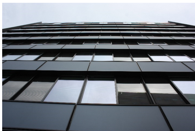
大成建設横浜支店太陽光発電設備(その5)
