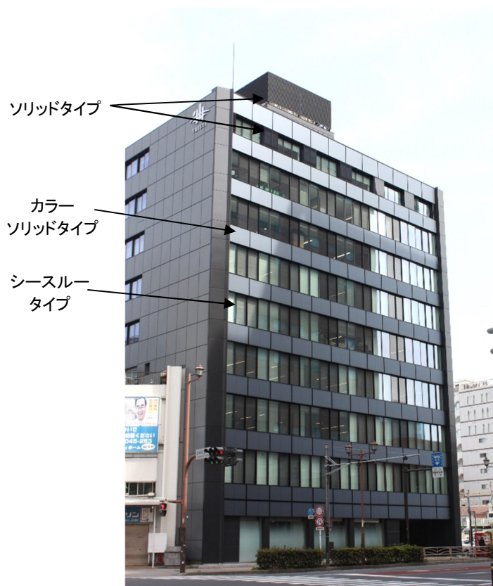
大成建設横浜支店太陽光発電設備(その1)
