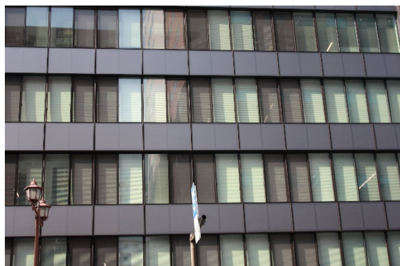
大成建設横浜支店太陽光発電設備(その4)
