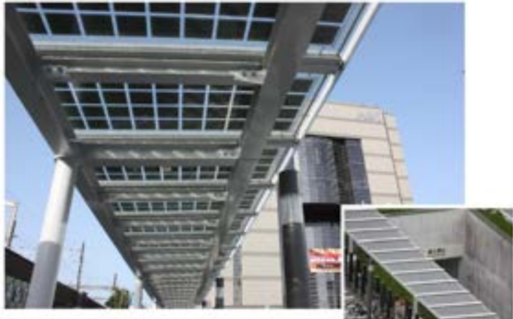
静岡県・静岡市シェアサイクルサービス「PULCLE」静岡駅北口駅前広場ステーション太陽光発電設備・3.7kW
