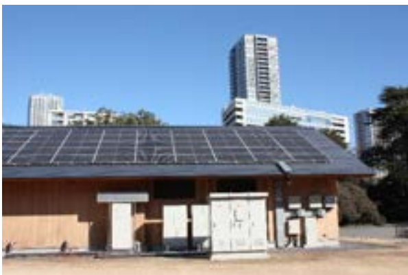
新宿御苑太陽光発電設備（その8）
