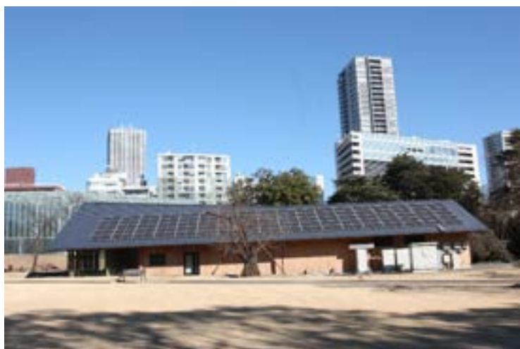
新宿御苑太陽光発電設備 (その1)
