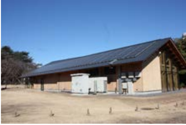
新宿御苑太陽光発電設備（その4）
