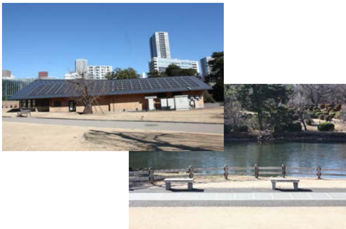
東京都・新宿御苑太陽光発電設備
