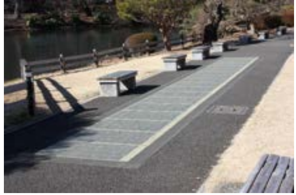
新宿御苑太陽光発電設備（その5）
