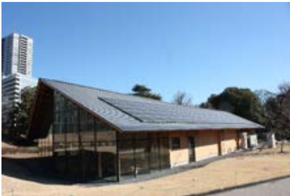
新宿御苑太陽光発電設備（その6）
