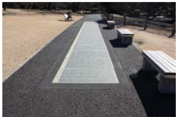
新宿御苑太陽光発電設備（その9）
