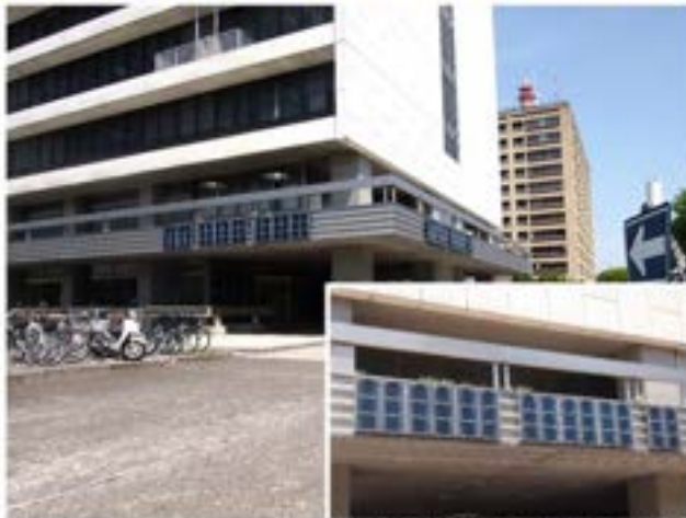
愛知県庁西庁舎ペロブスカイト太陽電池実証事業
