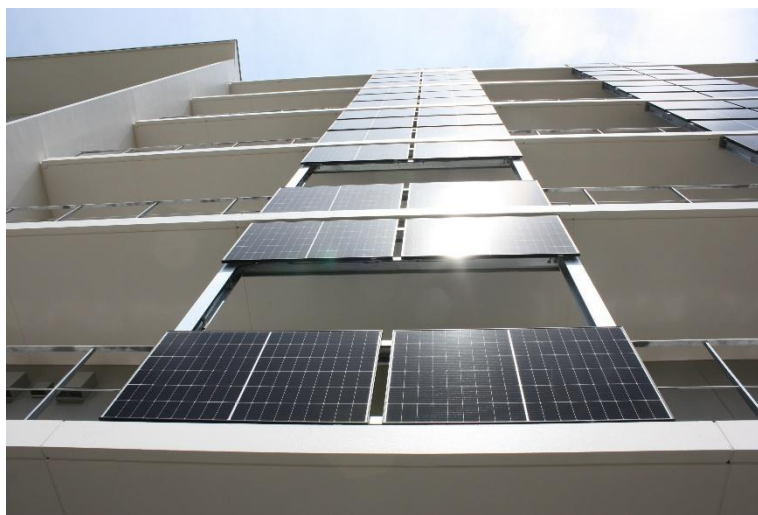
埼玉県・芝浦工業大学大宮キャンパス創発棟太陽光発電設備・約470kW
