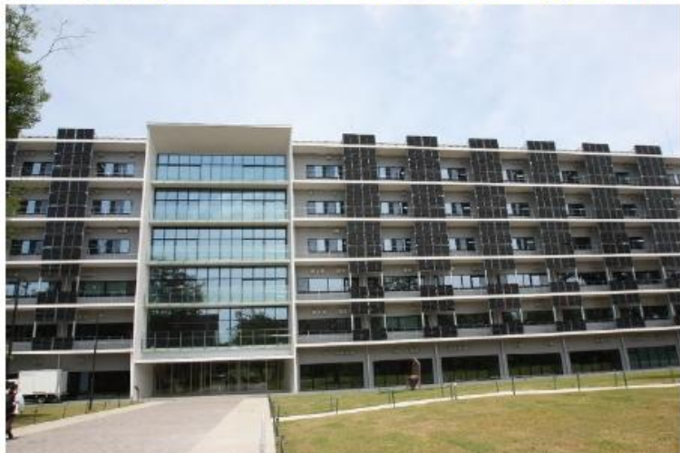
埼玉県・芝浦工業大学大宮キャンパス創発棟太陽光発電設備・約470kW
